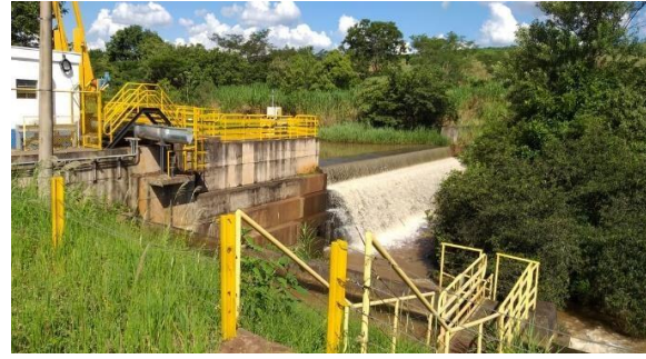
Chibarro : Barragem. Foto 2: Denilson Bertolaia – 14/02/2020.
